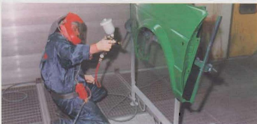
Lackierung einer Unifarbe mit 2-Komponenten-Material
